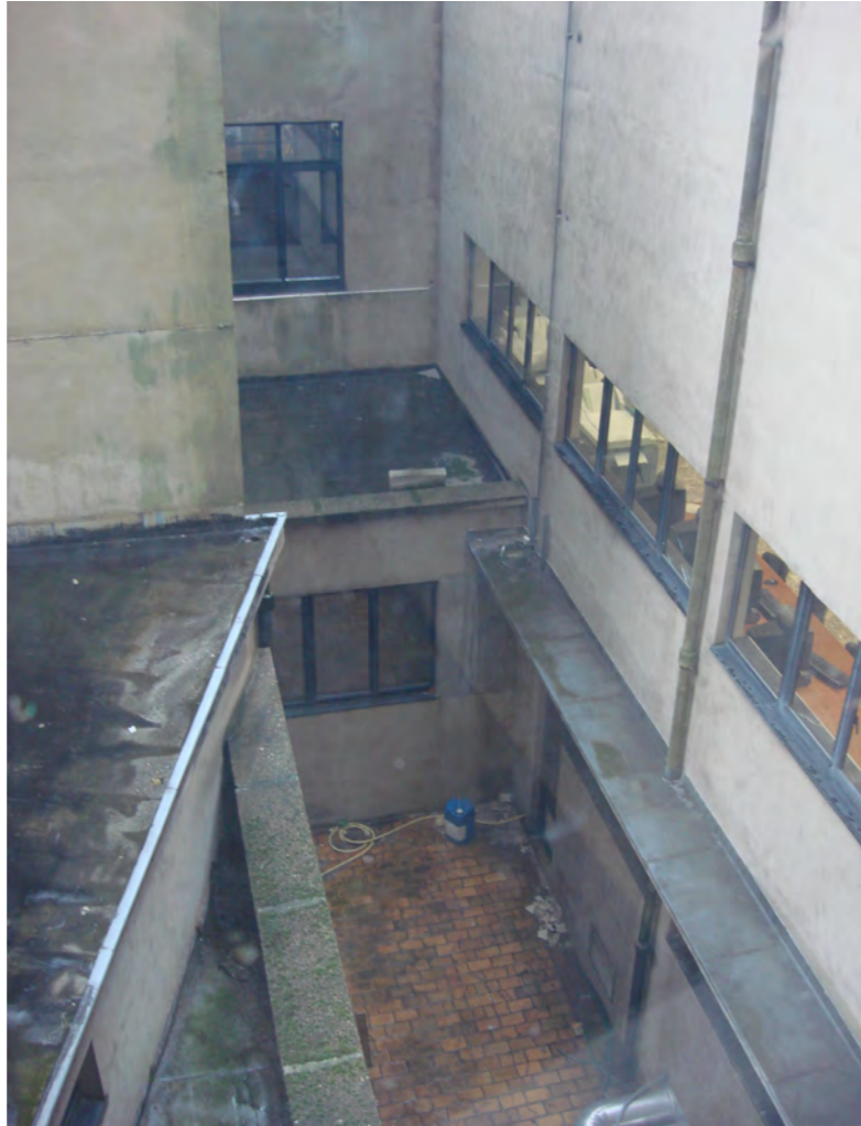
BESTAANDE TOESTAND - ZICHT VANUIT DE TOENTRAP
