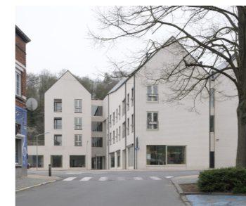
OCMW-dienstencentrum en serviceflats. Bron: DVVT & DRDH Architects
