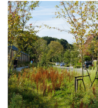
Een wadi zorgt voor een vertraagde afvoer en infiltratie van regenwater.
