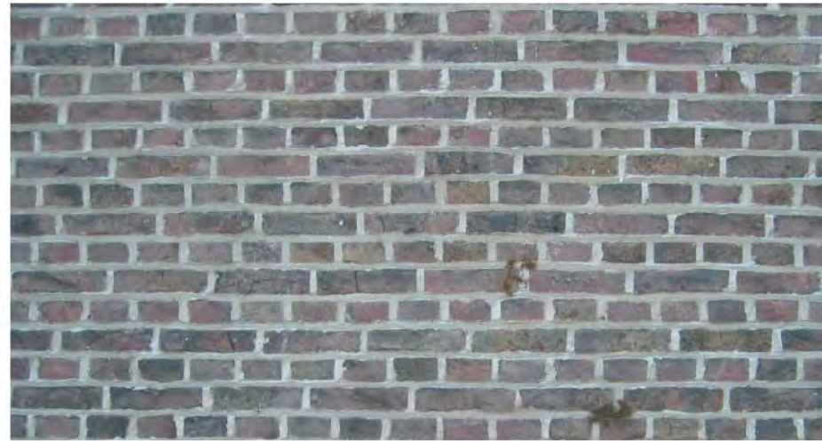
Bruingrijze gevelsteen aanwezig in de directe omgeving
