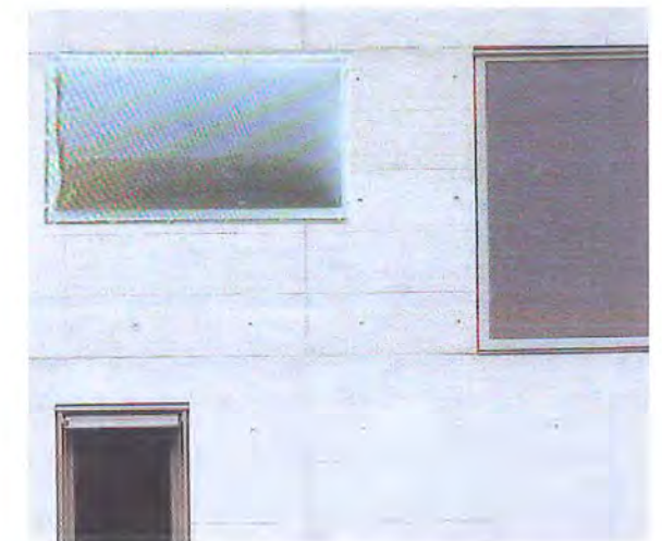
Opleidingsgebouw: prefab betonplaten. Ramen acrylaatkoepeles / floatglas
