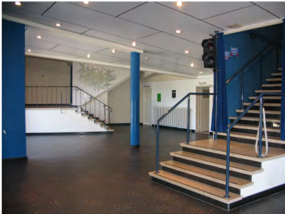
CC Luchtbal Schouwburg : de foyer is rechtstreeks verbonden met de zaal, heeft een slechte relatie met de cafetaria en heeft aanzienlijke technische problemen van akoestische en bouwphysische aard...
