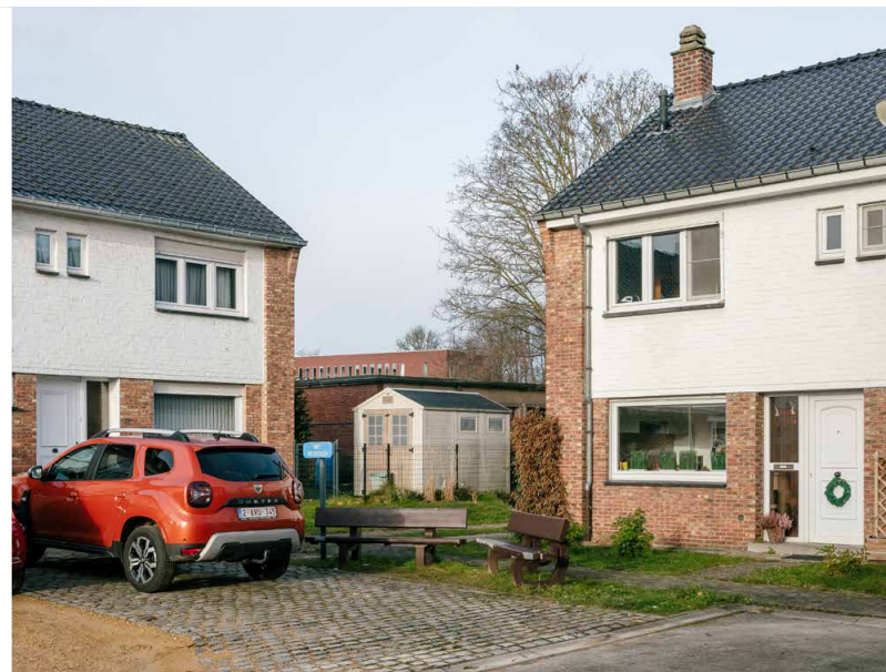
In Ravenstein (Tervuren) heeft een sociale huisvestingsmaatschappij een groot deel van de wijk in handen. © Stijn Bollaert
