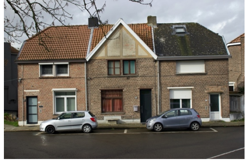
Rechts: Goed bewaarde hoek van 3 woningen (de voordeuropeningen werden wel verlaagd, en de dakbedekkingen werden vernieuwd samen met het schrijnwerk)
