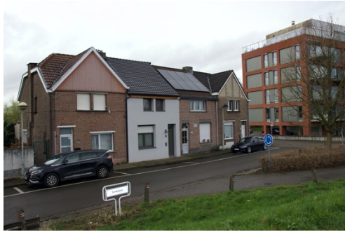
De bouw van de Waterkant zorgde voor schaalbreuk met de Tuinwijk
