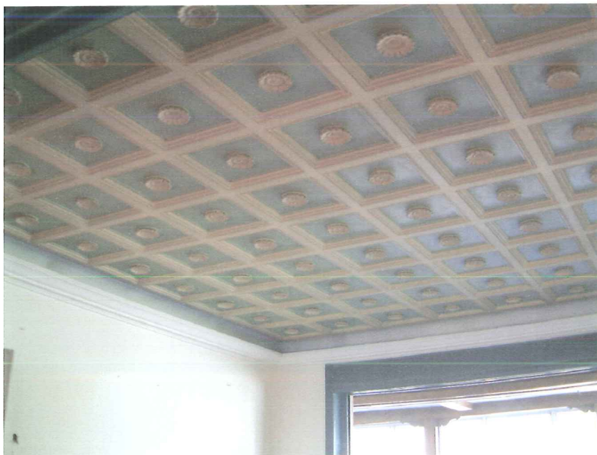
Het gedecoreerde plafond wordt gerestaureerd.
