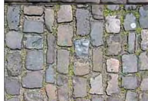
Bestaande kasseien in de Draakstraat.
