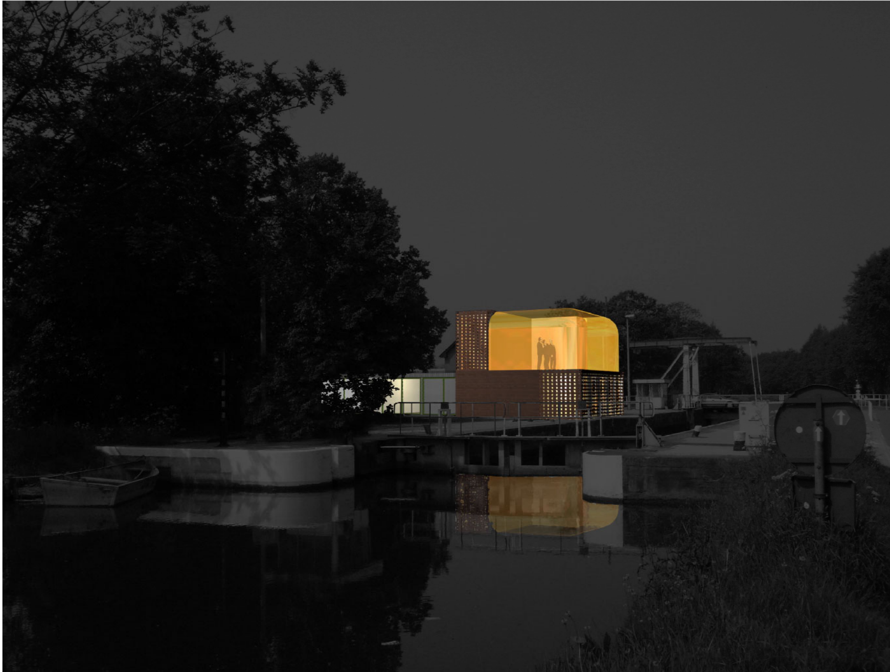
het bedieningsgebouw als een lichtbaken langst het kanaal Dessel-Turnhout-Schoten
