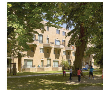
Vriendelijke park appartementen die met hun voeten in het park staan - Militair Hospitaal, Collectief Noord architecten
