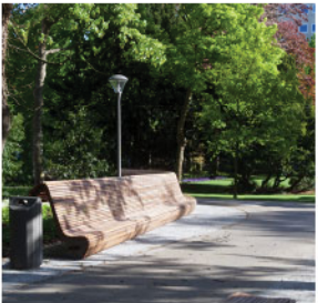
Harmoniepark Antwerpen, waarbij een lichtgekleurde bitumenlaag op het afgefreesde asfalt is aangebracht, ontwerp en uitvoering door LAND
