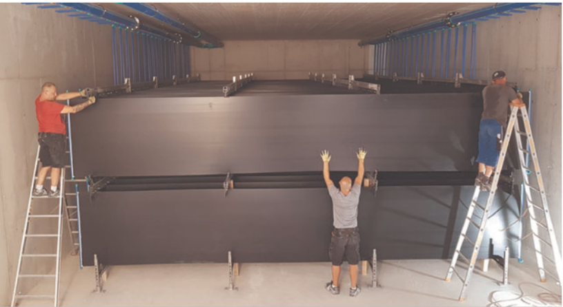
opbouw warmtewisselaar, multiQ.energy
