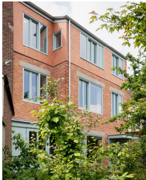
eigen kantoren - m u r m u r architecten dakverdieping in matte terracotta tegels op een bestaand baksteen gebouw in dezelfde kleur bleek schrijnwerk en luifeltje bij de achterdeur
