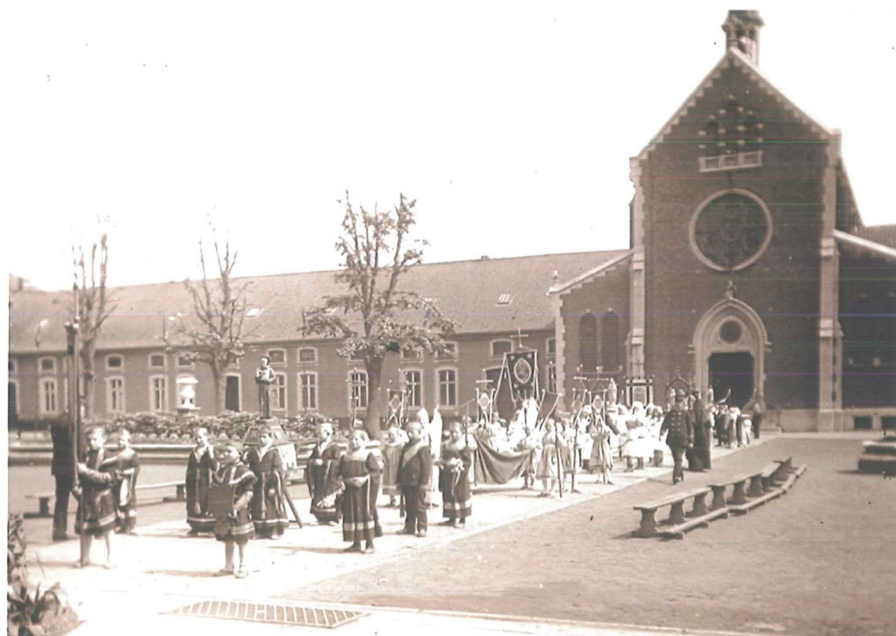
Van kapel tot schoolgebouw De Zande | Ruiselede 09.04.2008
