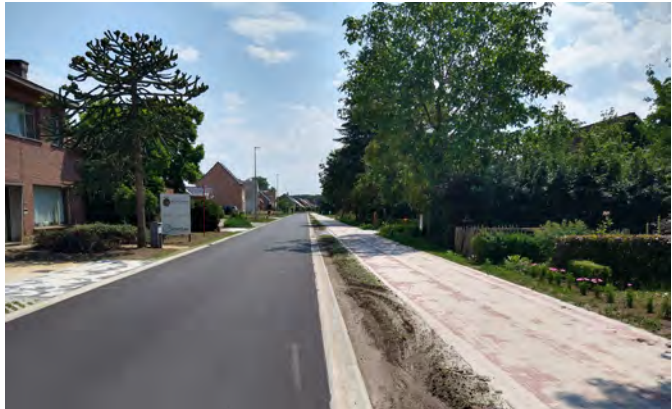
pas aangelegd fietspad tussen Zoersel en Eindhoven
