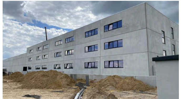
Een verblijf voor 168 seizoensarbeiders in Brustem (Foto: Jozef Groughs)
