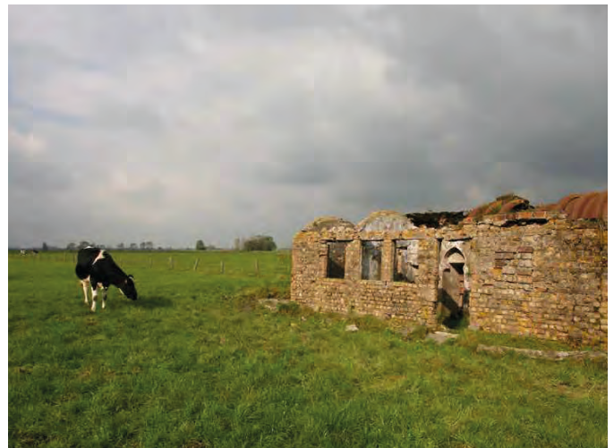
Bunker de Groigne, Oudekapelle © Vlaamse landmaatschappij
