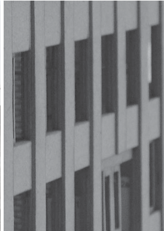
Nieuwbouw 'de Springplank', Brugge
