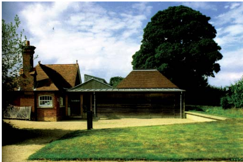
Ensemble van gebouwen uitgedrukt door middel van de dakvolumes - Referentie: Tony Fretton architects, Artsway Centre for Visual Arts, Sway Hampshire, United Kingdom
