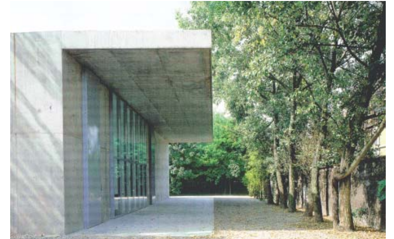
Overkragende luifel als overgang tussen binnen en buiten - Referentie: Herzog & De Meuron architects, studio Rémy Zaugg, Mulhouse
