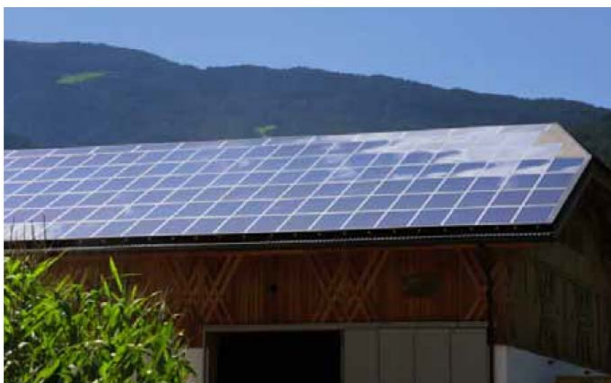
schuine daken geschikt als dragers voor duurzame energie
