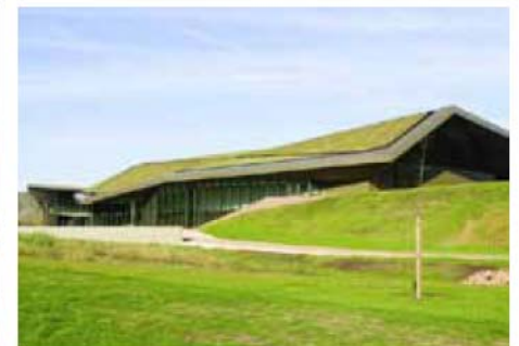
Groene daken met sedum
