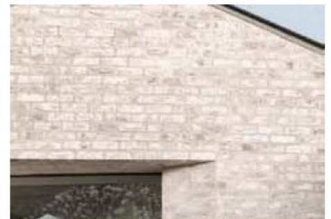
Bakstenen gevel met subtiel lichtgrijze tint
