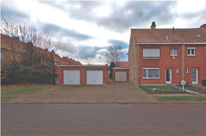
Lage aanbouwen: garages. Woningen met "steunberen".
