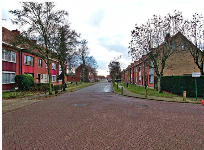
Verharde weginfrastructuur domineert het straatbeeld
