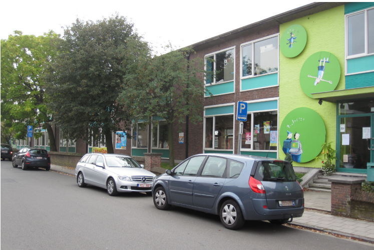
zicht op ingang basisschool Van Lerijslaan FOTO 01
