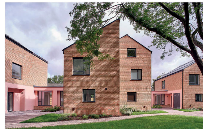
Materialisatie en dakvorm accentueren kleine korrel in groter geheel bell phillips architects - Sutton housing
