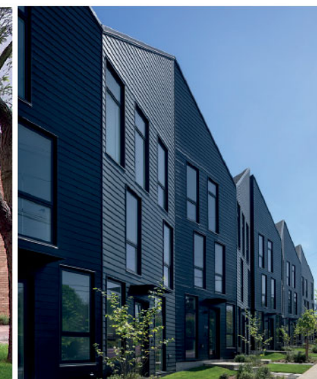
Architectuur zorgt voor geleding Waechter architecture - Origami house
