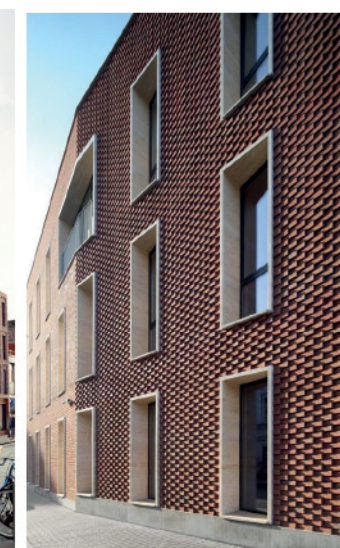
Geleding door knik Fachadas ladrillo
