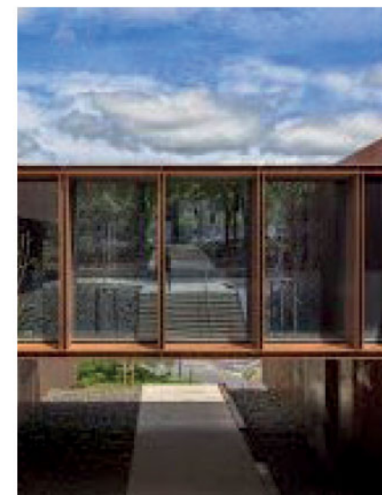
Passerel op verdieping
