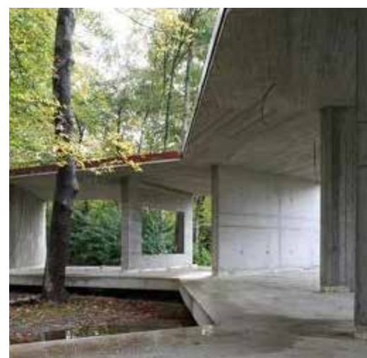
referentiebeeld: fundering ifv sparen van boomwortels
