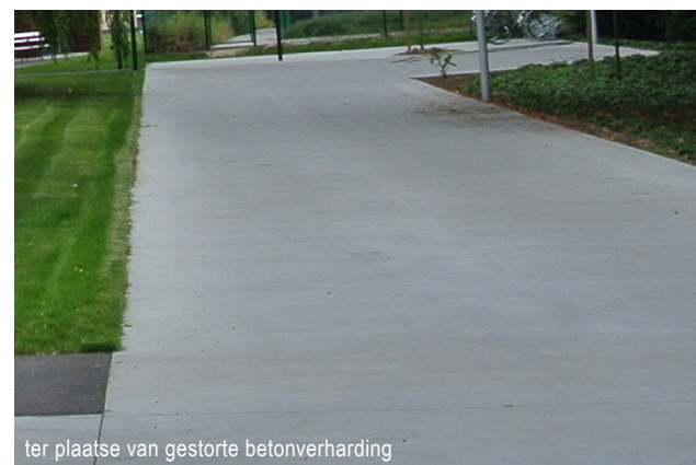
hoogteverschil opvangen met een grastalud
