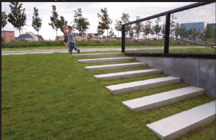
Tribunes: architectonisch beton
