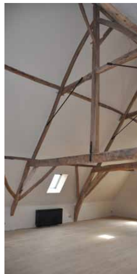
Na-isolatie zolder hoeve te Baaigem
