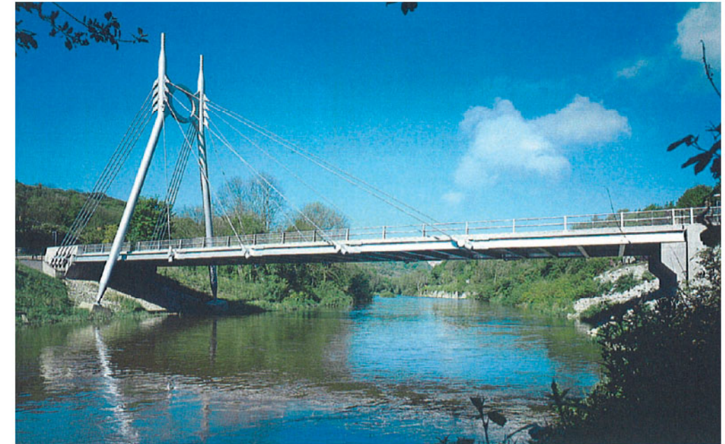
Jackfield brug in het Verenigd Koninkrijk Auto- en voetgangersbrug Hoofdoverspanning van 24 m
