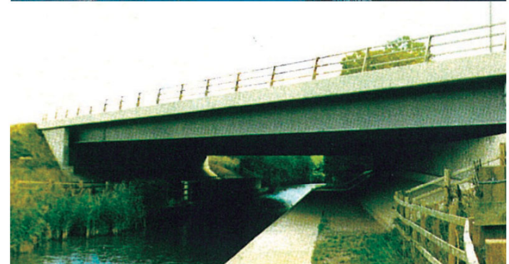
Autosnelwegbrug Hoofdoverspanning van 24 m
