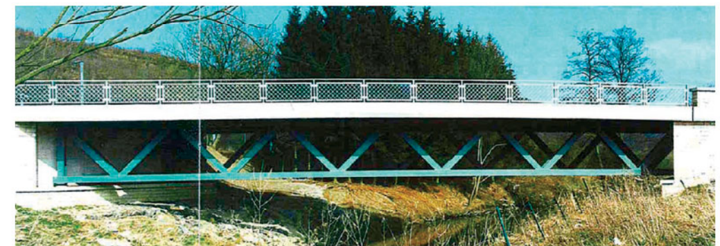
Brug over de Alzette in Luxemburg Auto- en voetgangersbrug Hoofdoverspanning van 31 m
