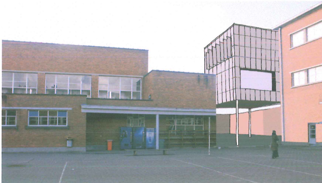
VERVANGBOUW 2 WEGGEBROKEN KLASSEN
