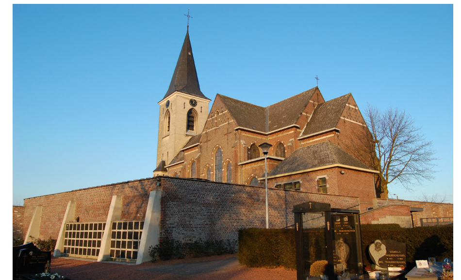
De massieve sokkel waarop de kerk is gebouwd is op sommige plaatsen 4 m hoog.
