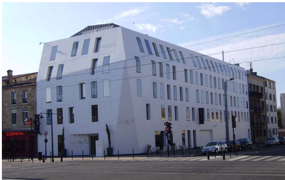
09. gebruikt kunststofplaten in gevel, Bordeaux
