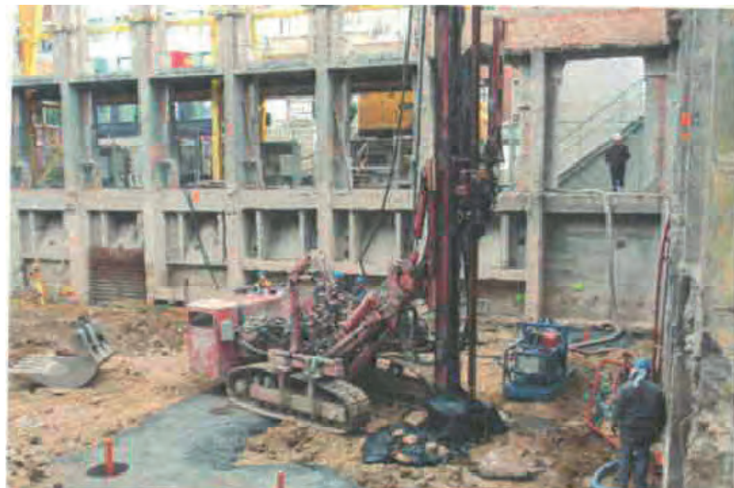
FIGUUR 2: VHP-GROUTING
