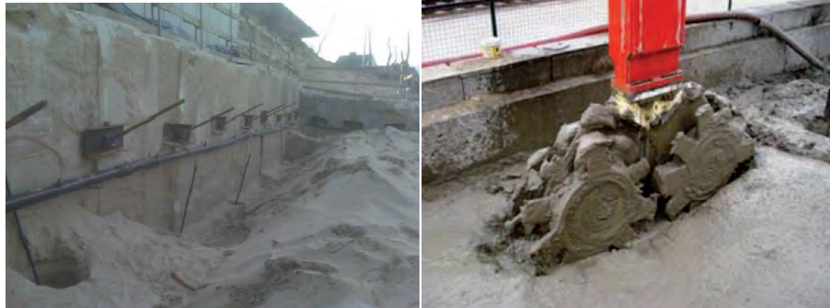
FIGUUR 1: CSM-WAND MET TREKANKERS
