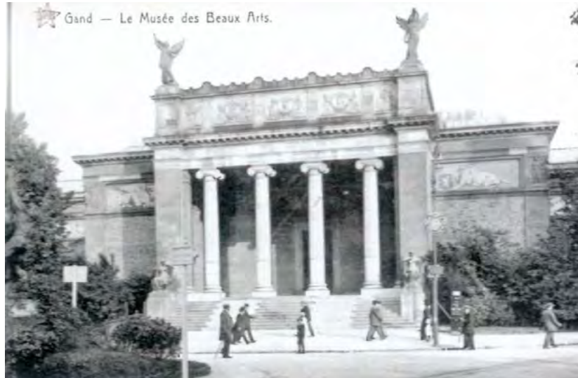
historische foto - Citadelpark
