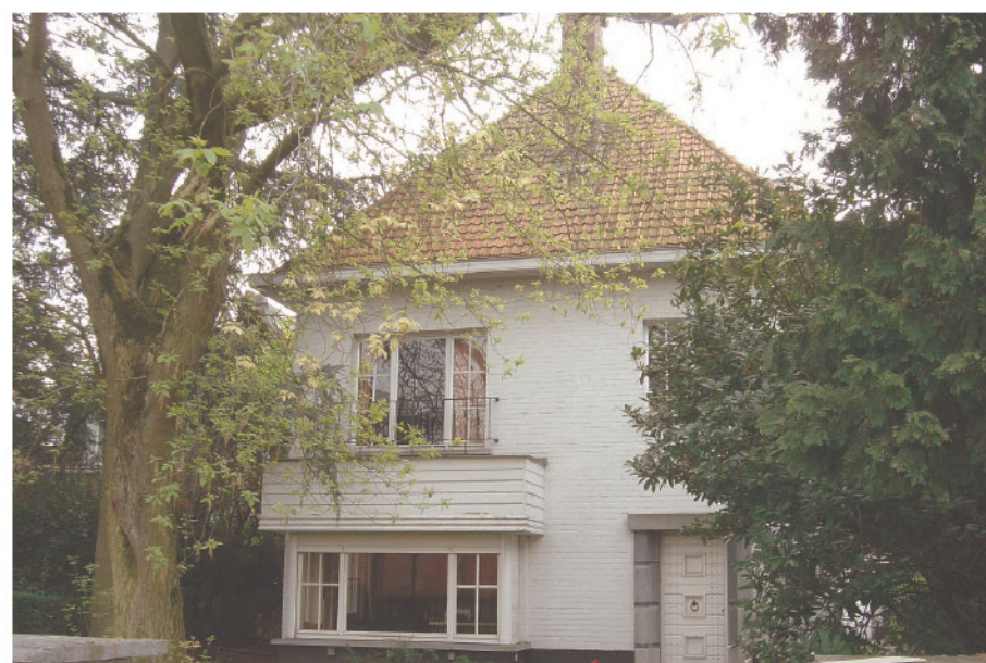
Woning Gent ECTV, 2010 (Bestaande woning)
