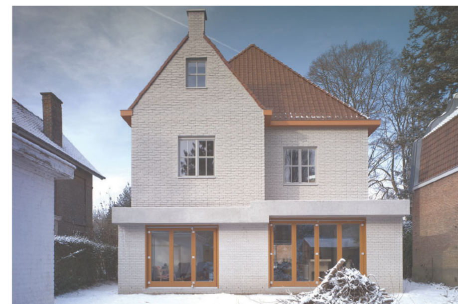
Woning Gent ECTV, 2010 (Buitenspouwblad werd vervangen na plaatsing isolatie )
