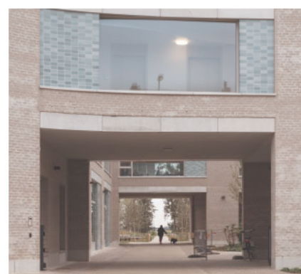
Woonzorgcentrum de Drie Platanen, Bovenbouw architecten
