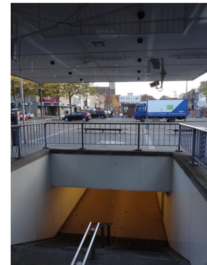
Zicht op de noordelijke ingang van de voetgangerstunnel ter hoogte van de fruitmarkt.
