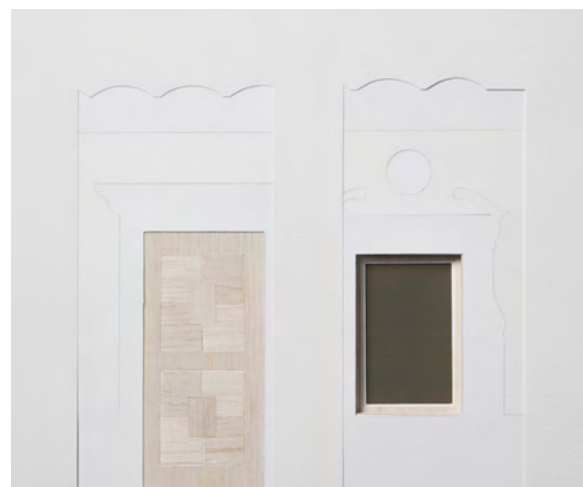
afb 25. Detail van de kalkpleister in 2 tinten, en een vlakke finerdeur als alter ego voor de historische deuren.
