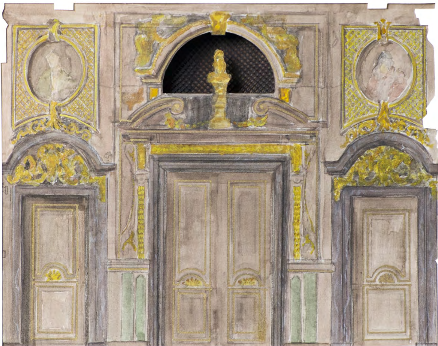
afb 12. Extractie van vuile lucht in een verborgen rooster boven de deur naar de collegezaal.
