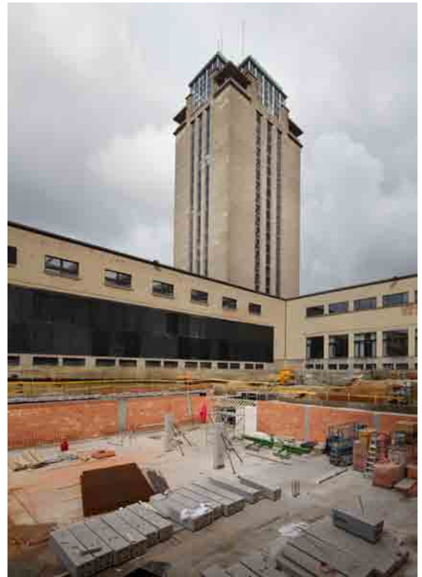
1201 Boekentoren Gent (Henry van de Velde), restauratie Universiteitsbibliotheek, Robbrecht en Daem i.s.m. Barbara Van der Wee en SumProject, gestart 2012
