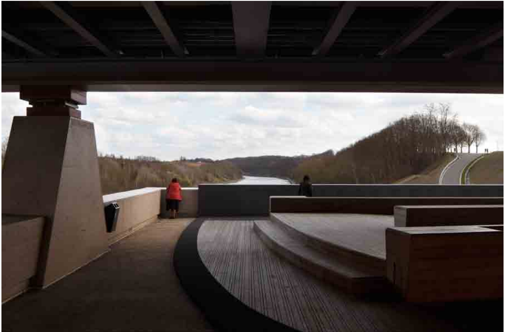
0229 Brug over het Albertkanaal, Vroenhoven, Ney & Partners, 2011
