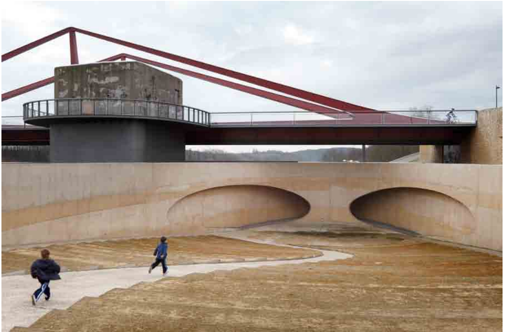
0229 Brug over het Albertkanaal, Vroenhoven, Ney & Partners, 2011
