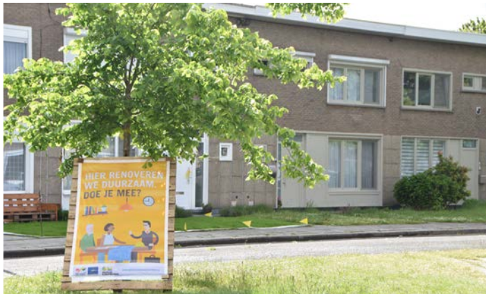
Collectieve renovatiestrategie via het Energiehuis © Stad Mechelen
