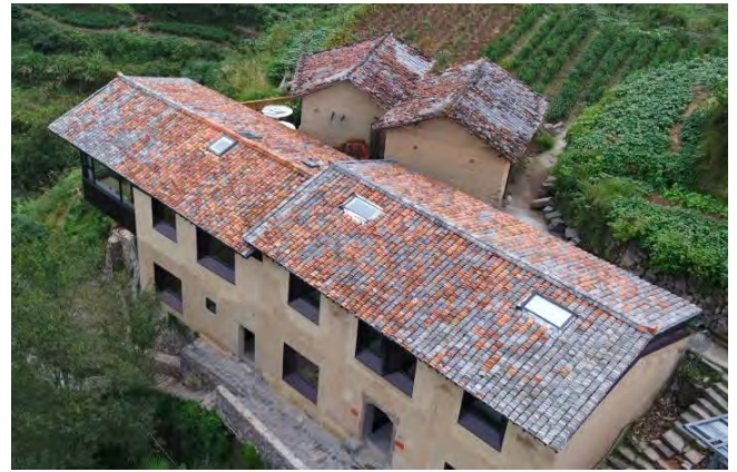
fig. 5.3 - verbouwing Songyang Chenjiapu - duurzame renovatie van bestaand patrimonium - renoveren binnen de bestaande buitenschil
