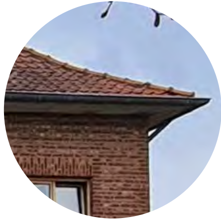
De typerende dakoversteek van het (schild)dak en zinken bakgoten en rode dakpannen
