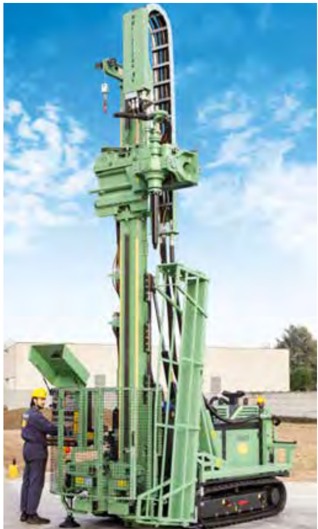
figuur 34 Voorbeeld van een RUPS machine (voor putboringen BEO-veld)
