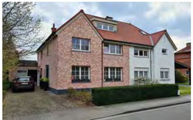
figuur 29 Beide buren hebben hun dak langs buiten geïsoleerd waardoor het volume leesbaar blijft. De gevelafwerking is echter verschillend, wat ten koste gaat van de harmonie van de cluster. Bovendien wordt in het linkse huis een heel ander type baksteen gebruikt, die niet aansluit bij de stijl van de tuinwijk.
