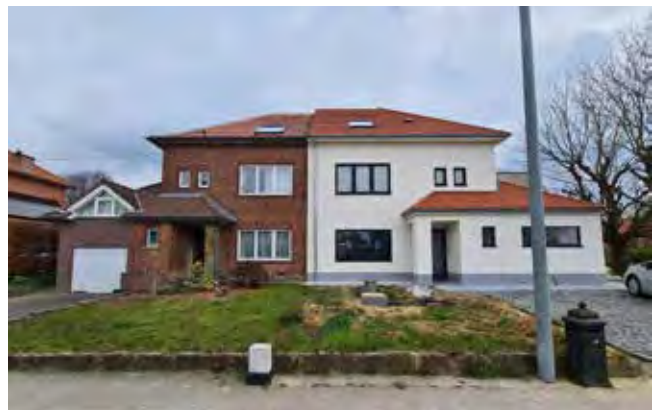
figuur 30 De rechtste eigenaar heeft zijn dak en gevel langs buiten geïsoleerd. Om terug tot een harmonieus geheel te komen, zal de linkse buur dezelfde parameters moeten hanteren.
