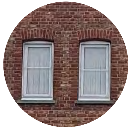
Specifiek metselwerkverband met accenten t.h.v. de rollaag
