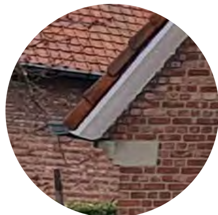
Consoles en andere details uitgevoerd in zichtbeton
