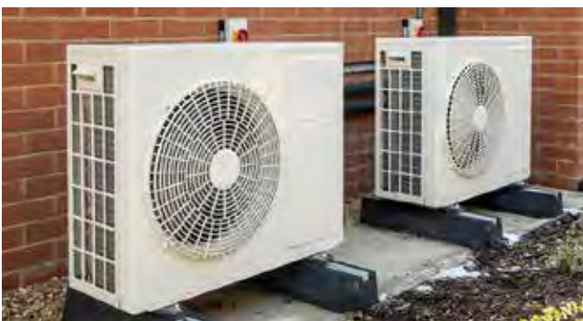
figuur 35 Standaard buitenunit L/W warmtepomp (740x884x388)
